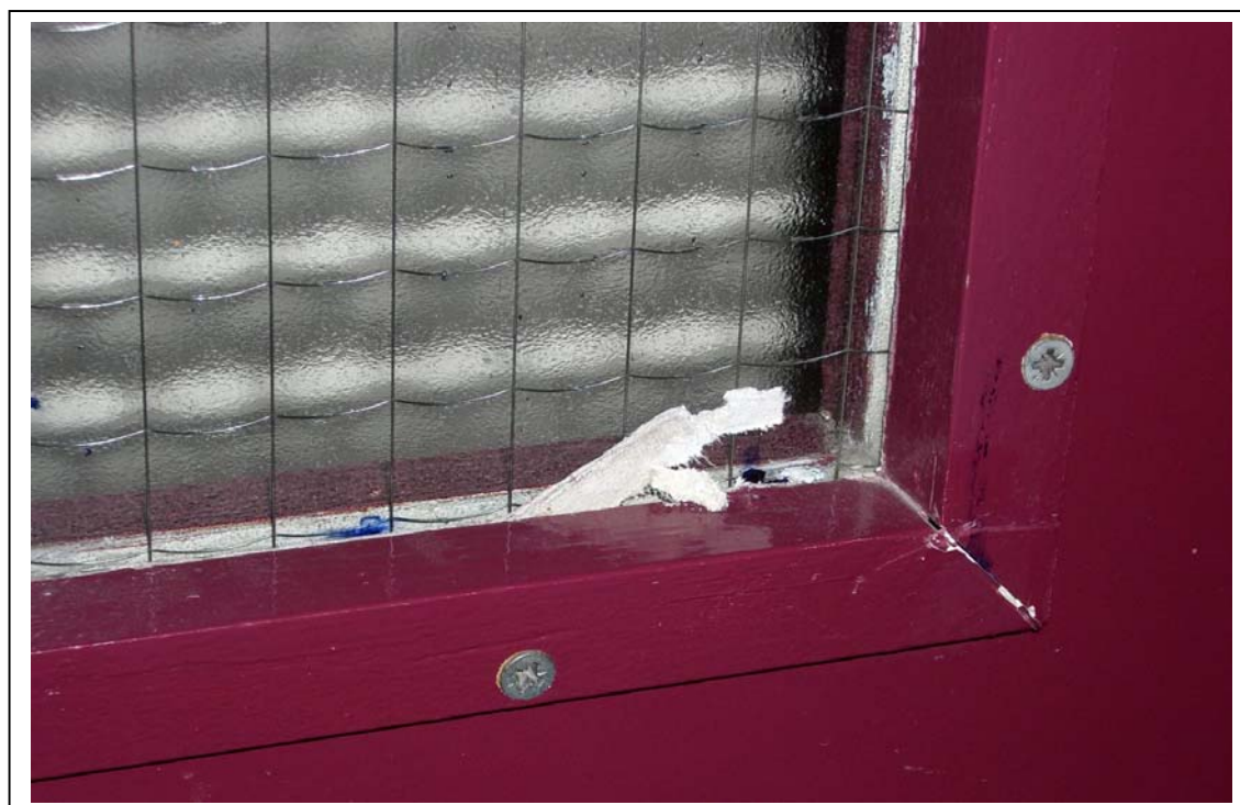
Vue du joint amianté sur oculus de porte
