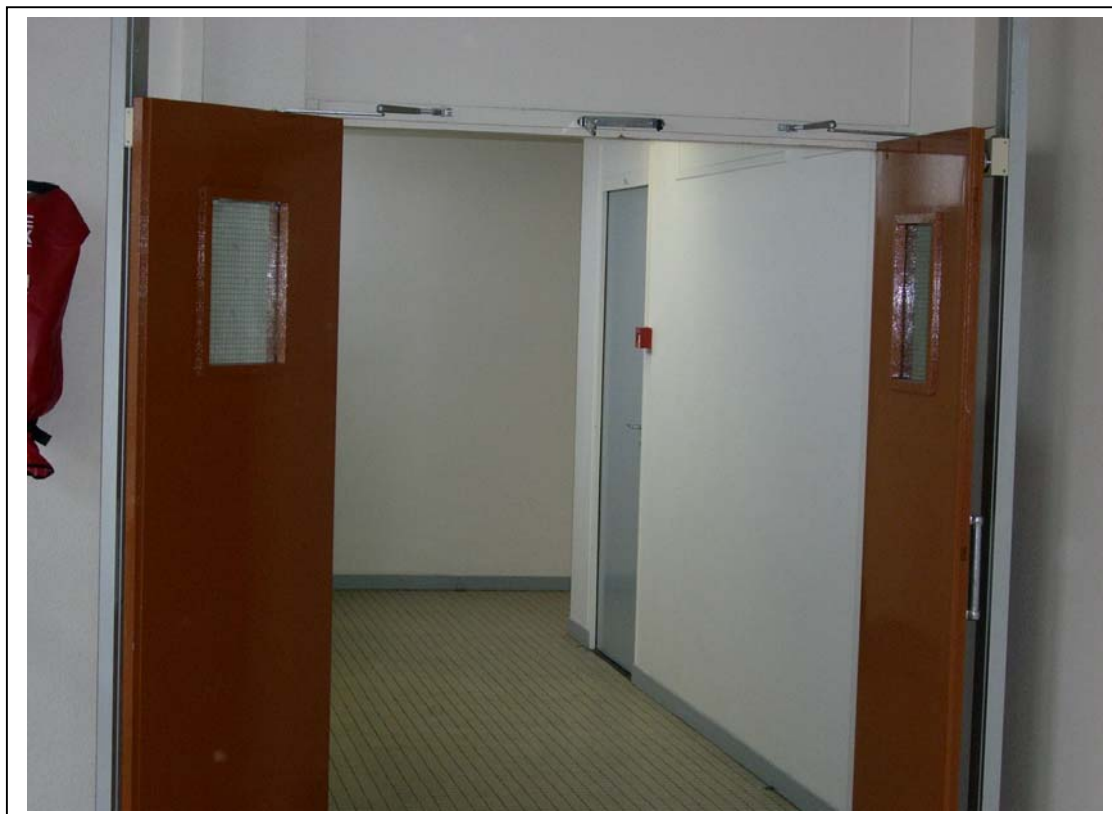
Vue portes de sectionnement coupe-feu avec oculus
